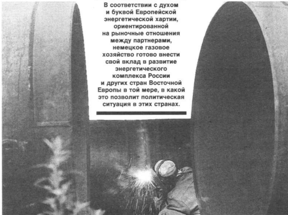
Идут сварочные работы на строительстве газопровода. Почти 70 проц. всех инвестированных немецким газовым хозяйством средств в 1991 году были направлены на обновление и строительство сети трубопроводов. Создан необходимый технический инструментарий. Его основным звеном является система газопроводов со всеми относящимися к ним установками, устройствами и сооружениями. Немецкие компании строят, содержат и эксплуатируют их за счет своих собственных средств.
